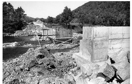
Bjerkreimbrua over elva for den nye E39 ca.1970.
